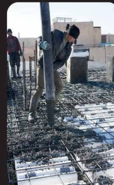
عدم حرکت بلوک ها هنگام بتن ریزی
