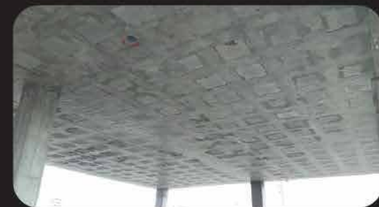
امکان اجرای دهانه بلند
